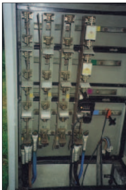
Obr. 6: Rozváděč po vyčištění
