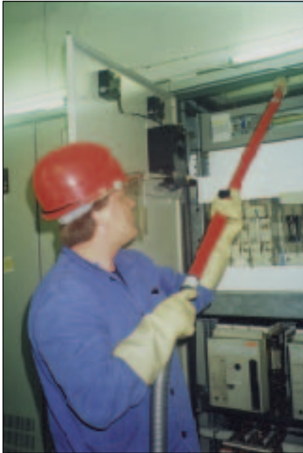
Obr. 11: Čištění rámu rozváděče
