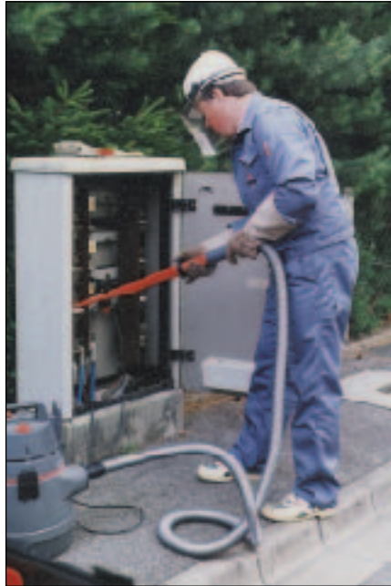
Obr. 9: Čištění rozváděče
