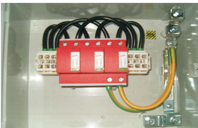
Obr. 4 Přípojková skříň se svodičem SPD T1 – DCK Holoubkov
