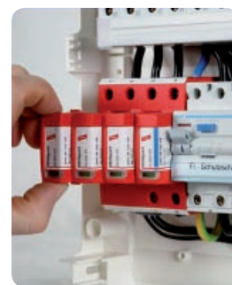
Vyjímatelné moduly s přepěťovou ochranou
