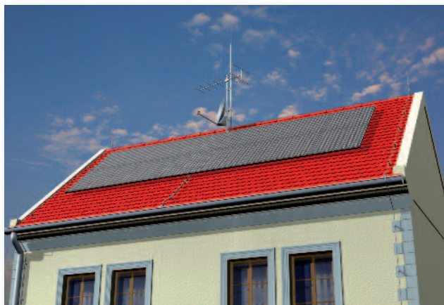
Fotovoltaický článek na střeše rodinného domu.
