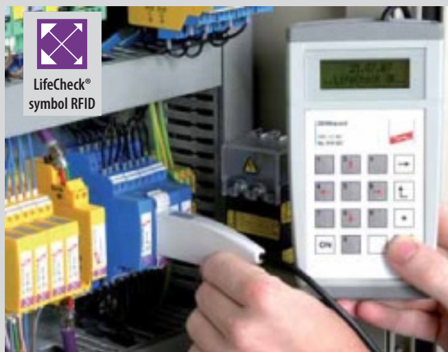
Testování ochranného modulu s pomocí technologie RFID (LifeCheck®).
