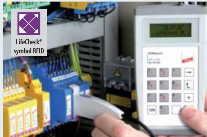
Kontrola ochranného modulu s pomocí techniky RFID.
